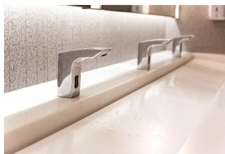
Рис. 9.5 Смеситель с датчиком движения: инфракрасный свет обнаруживает движение руки
