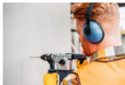
Рис. 3.2 Шум, вызванный ремонтом здания
